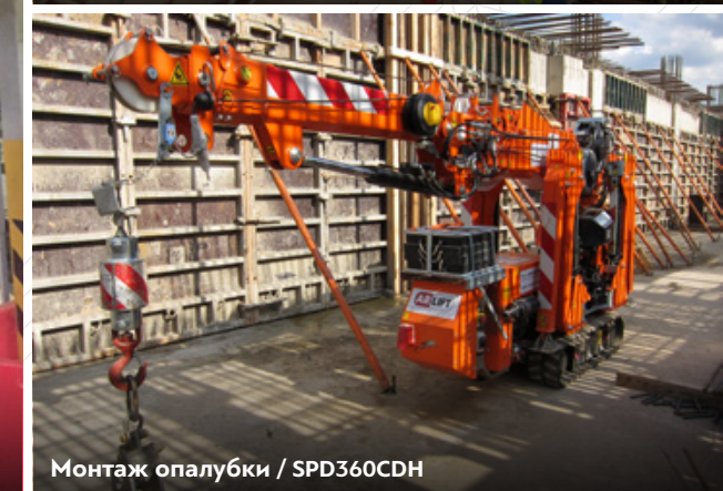
Монтаж опалубки / SPD360CDH
